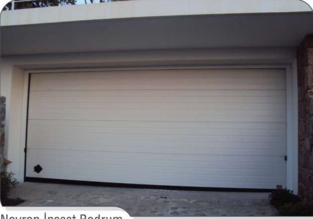
Novron İnşaat Bodrum
